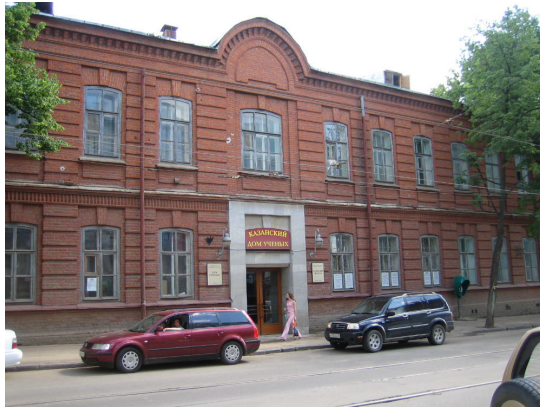
Рис. 4. Здание бывшего Александринского приюта, построенного на средства О.С. Александровой
