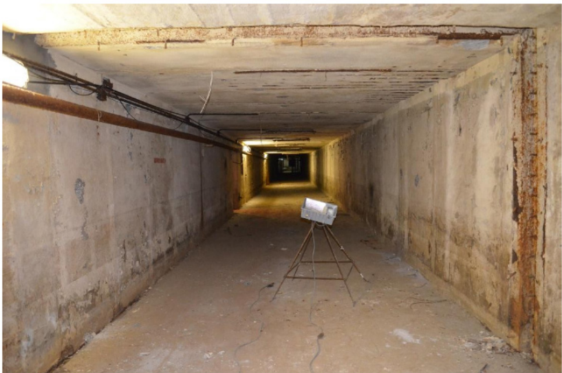
Пешеходно-транспортный туннель. Общий вид
