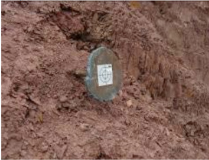
Рисунок 4 - Репер с безотражательной пластиной, установленный в откосе
