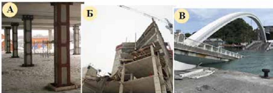
Рис. 9. Предвестники (А) и результаты (Б, В) сбросов прочности железобетонных конструкций и сооружений
