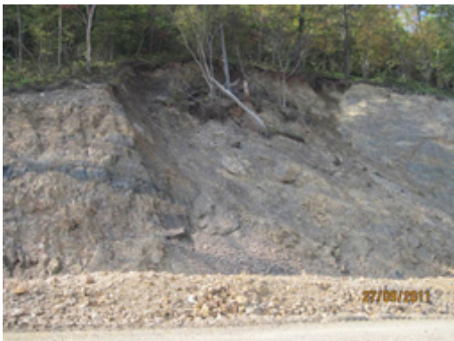
Рис. 11. Оползень в верхней части техногенной выемки (склон ВЭ, 4707 км трассы). Фото Е.А. Мясникова.
