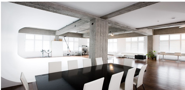
Рис. 1. Бетонные колонны в жилом интерьере
