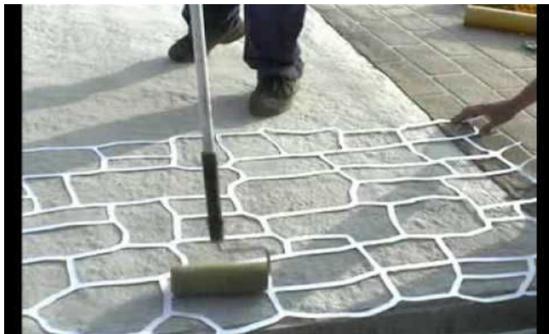
Рис.4. Трафарет для создания фактурной поверхности бетона
