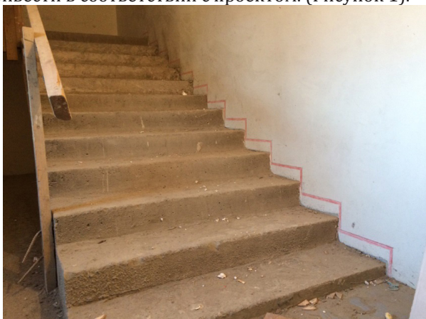
Рисунок 1 – Эскиз лестницы, полученный в ходе выноса проектных отметок, где красная линия – проектное положение лестницы.
